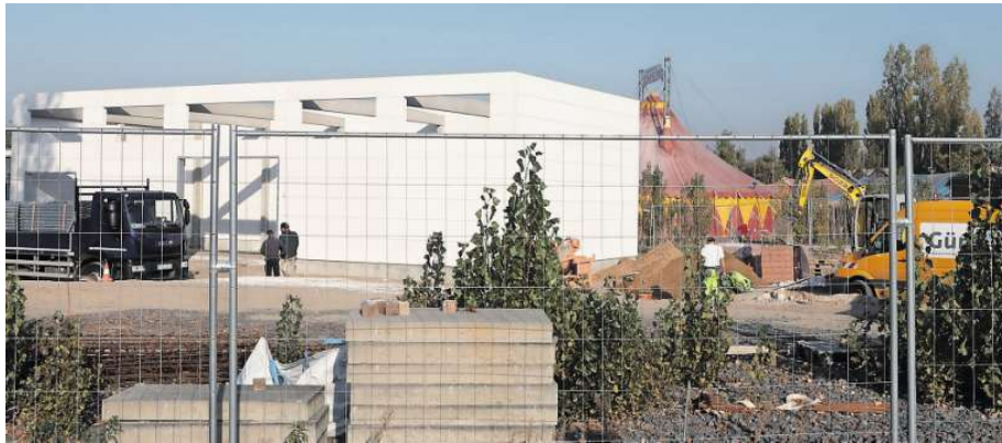
Im Bau. Das neue Betriebsgebäude für den Volkspark an der Biosphäre wird voraussichtlich Ende des Jahres fertig. Bereits dafür mussten Parkflächen weichen. Foto: Andreas Klaer
